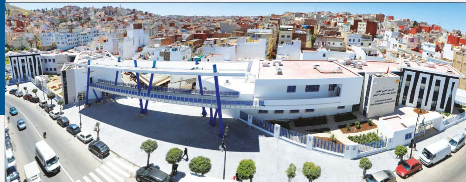
Centre Médical de Proximité - Fondation Mohammed V pour la Solidarité - Tanger
